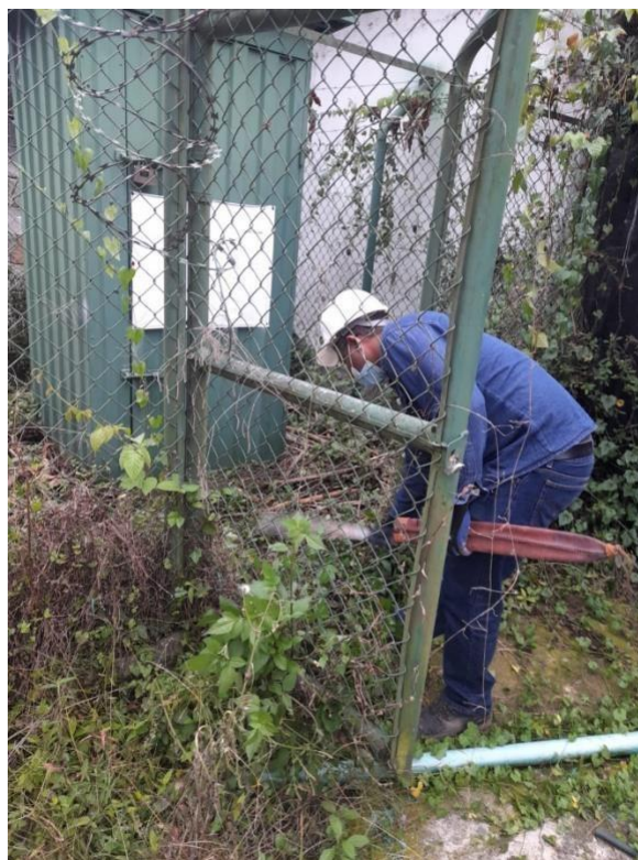
Ilustración 28: Limpieza de estación
