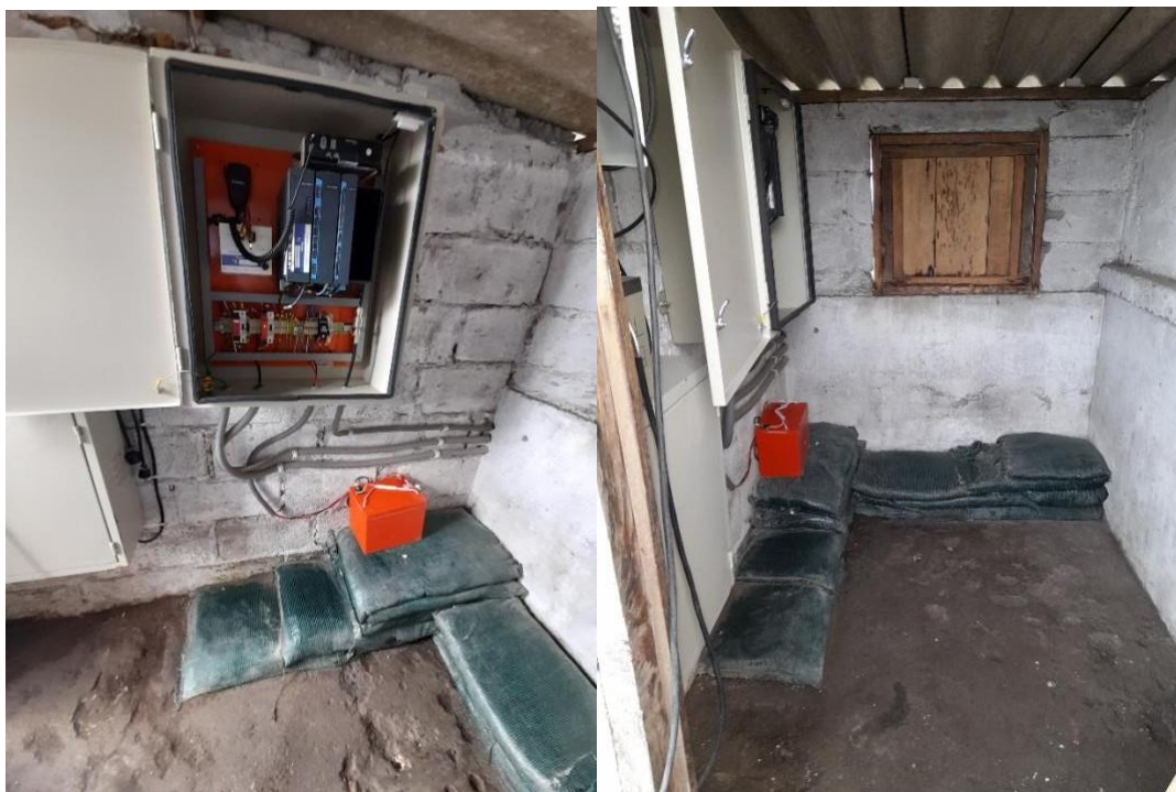
Ilustración 83: Estación después del mantenimiento
