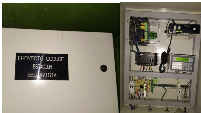
Ilustración 14: Estado de los equipos de telemetría.
