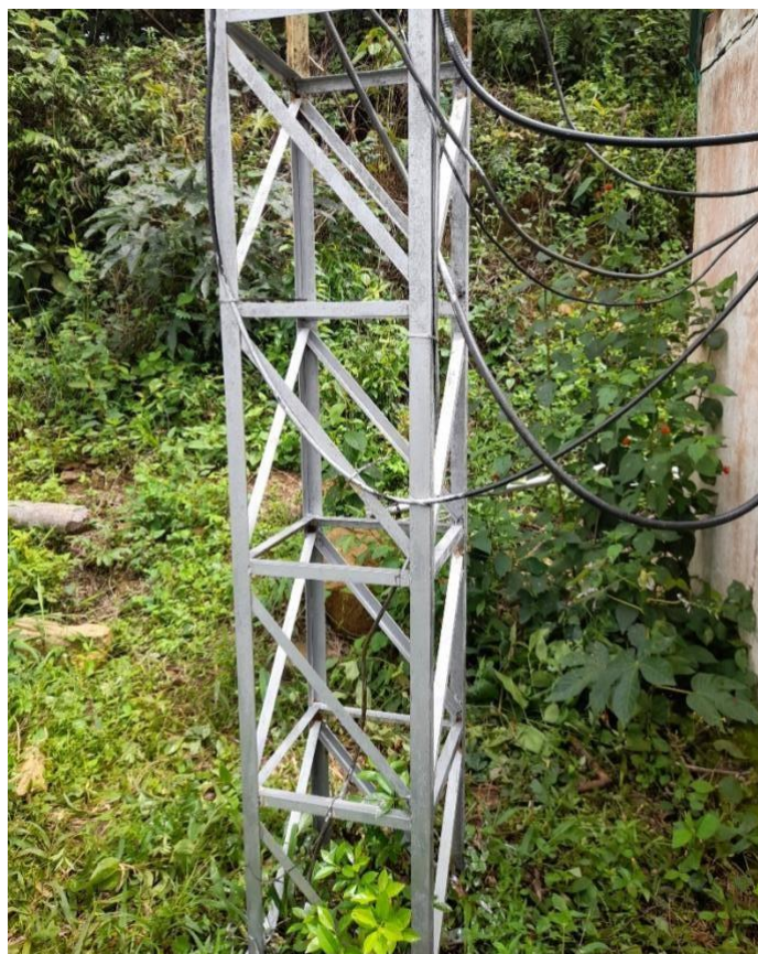
Ilustración 95: Pintura de estructura de la antena.
