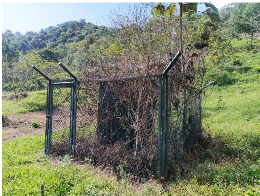
Ilustración 35: Estado de la estación
