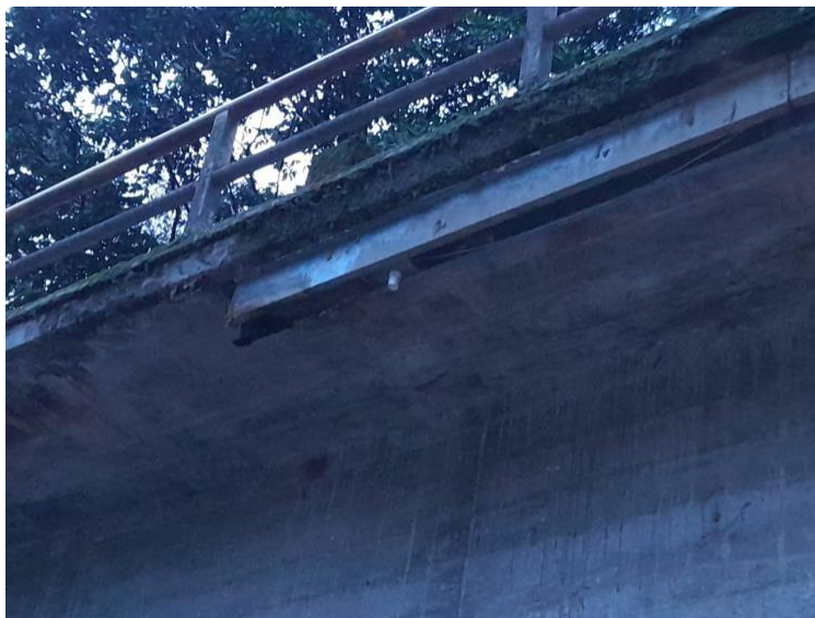
Ilustración 34: Ubicación del sensor de nivel (160m de la estación)
