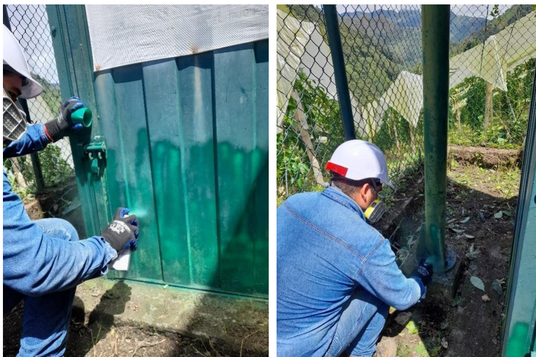
Ilustración 88: Aplique de pintura y limpieza de partes oxidadas
