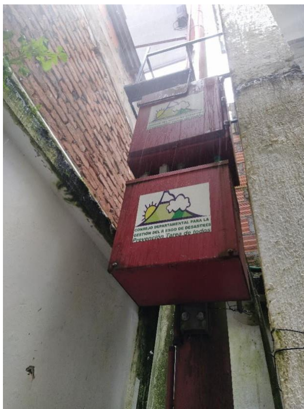
Ilustración 57: Ubicación del sistema de alarma dentro de la estación de policía
