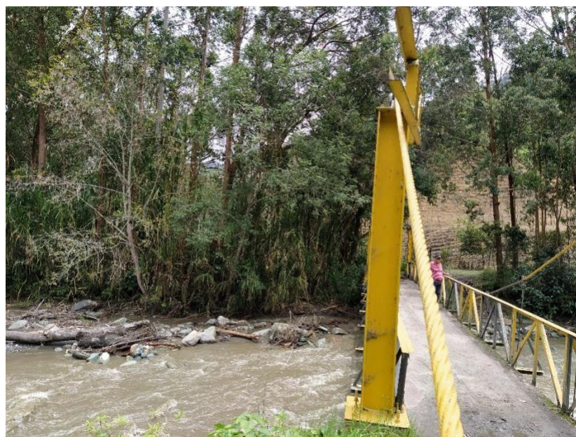
Ilustración 26: base puente para instalación de nuevo sensor de nivel
