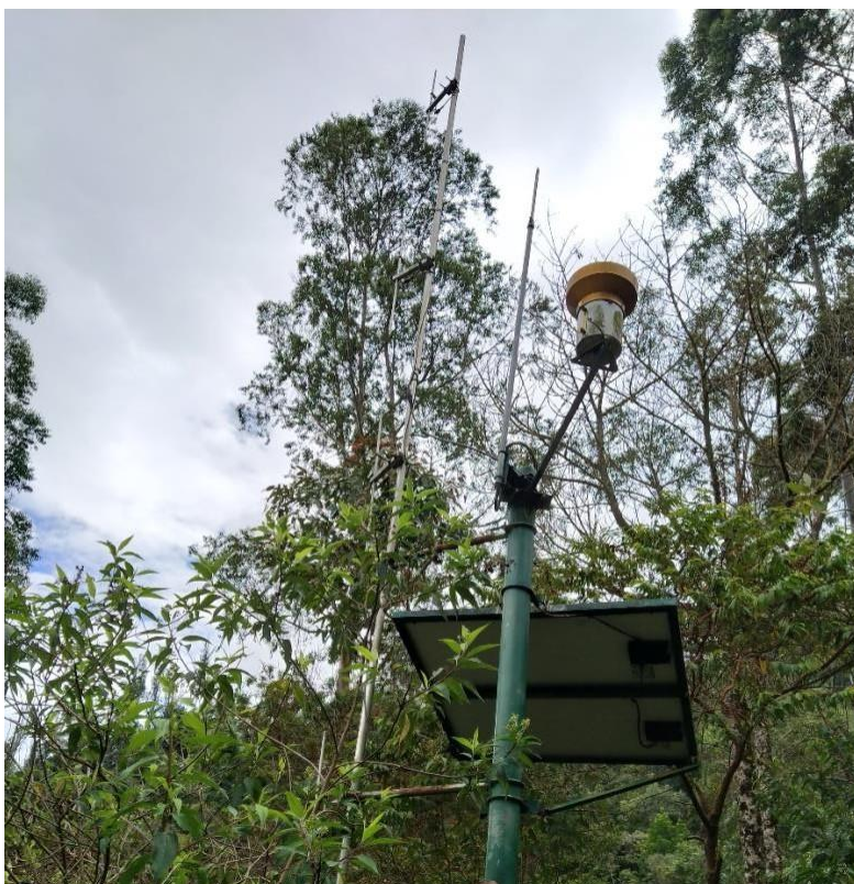
Ilustración 11: Vegetación que obstruye la radiación hacia los paneles solares y la medición de lluvia
