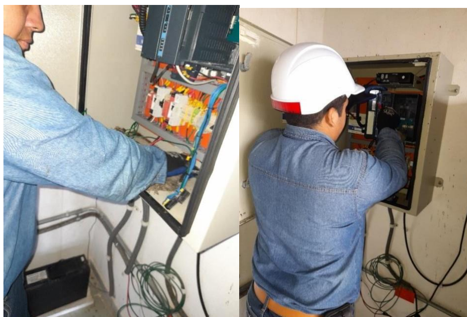
Ilustración 92: Limpieza de equipos.
