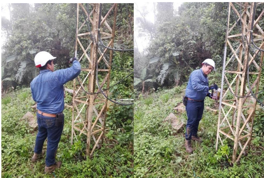
Ilustración 94: Limpieza de la estructura de la antena.
