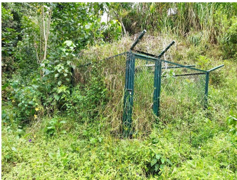
Ilustración 17: Estado inicial de la estación
