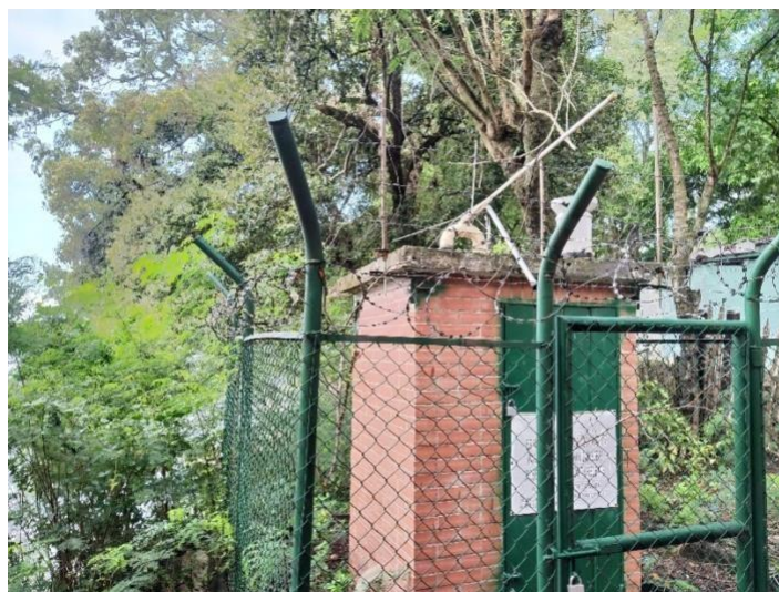
Ilustración 45: Estación con antenas vandalizadas.
