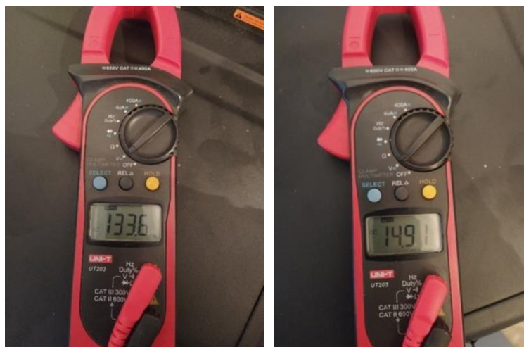
Ilustración 98: Voltaje AC de la estación y voltaje de batería.
