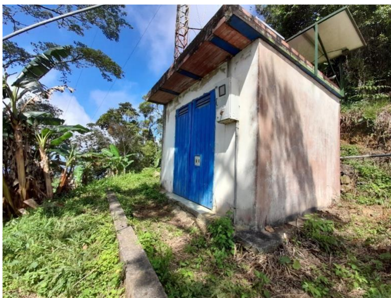
Ilustración 96: Estado final de la estación.
