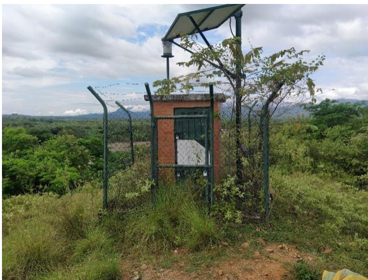
Ilustración 65: Estado inicial de la estación
