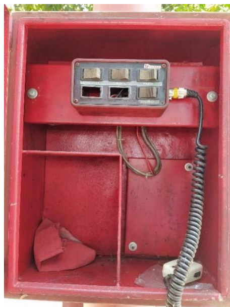
Ilustración 53: Activación de alarma y perifoneo
