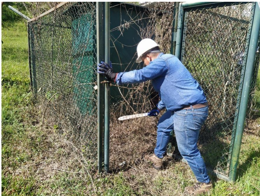
Ilustración 37: Limpieza del acceso a la estación
