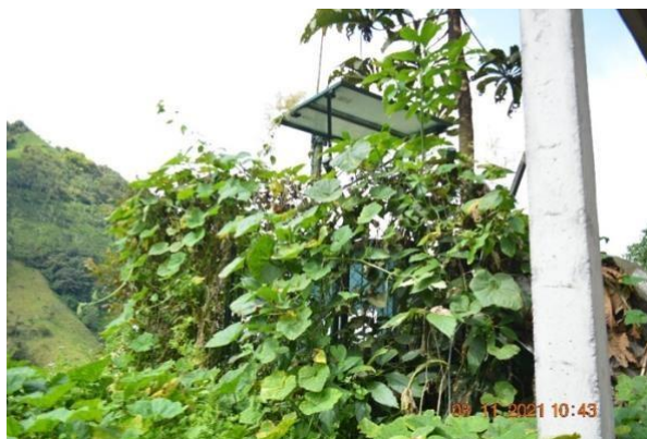
Ilustración 86: Estado inicial de la estación
