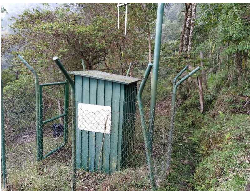
Ilustración 12: Estado final, limpieza parcial de la estación.
