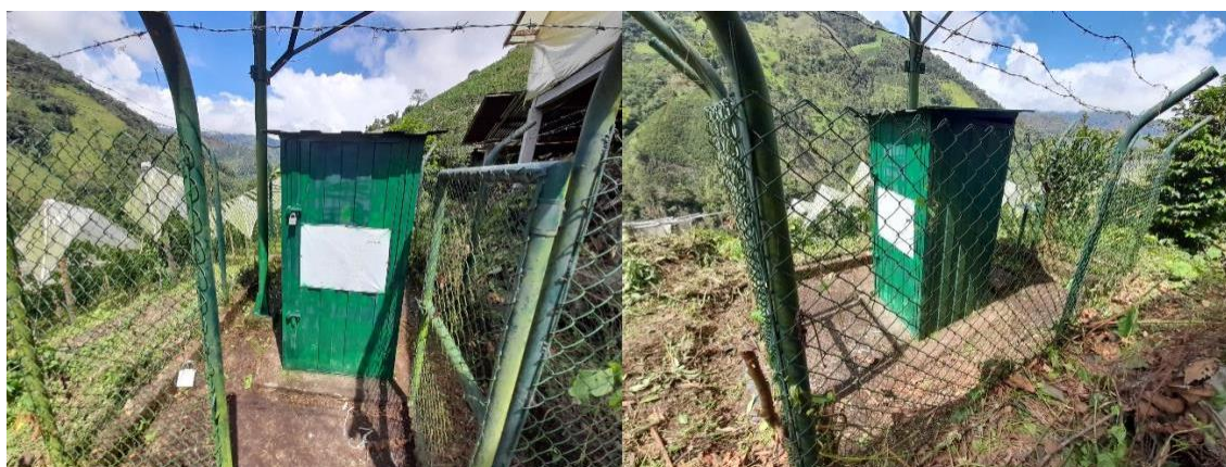
Ilustración 90: Estado final de la estación.
