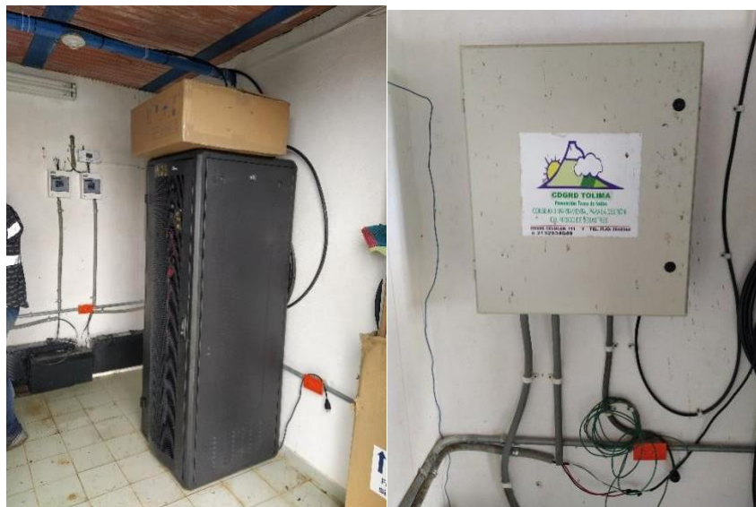
Ilustración 91: Estado inicial de la estación
