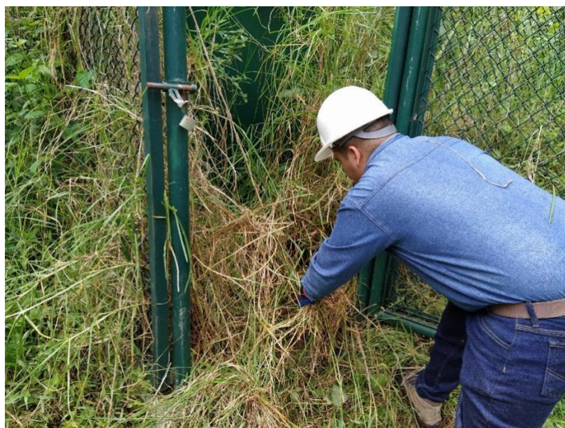
Ilustración 19: Limpieza del acceso a la estación
