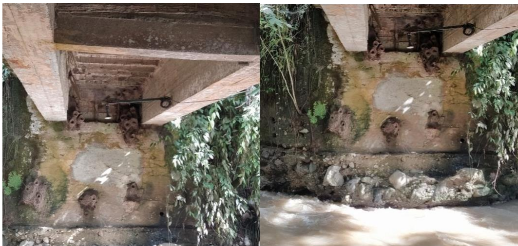
Ilustración 39: Sensor de nivel ubicado debajo del puente.
