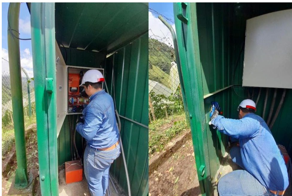
Ilustración 89: Limpieza interior de la estación
