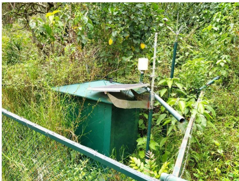
Ilustración 18: Estado inicial de la estación
