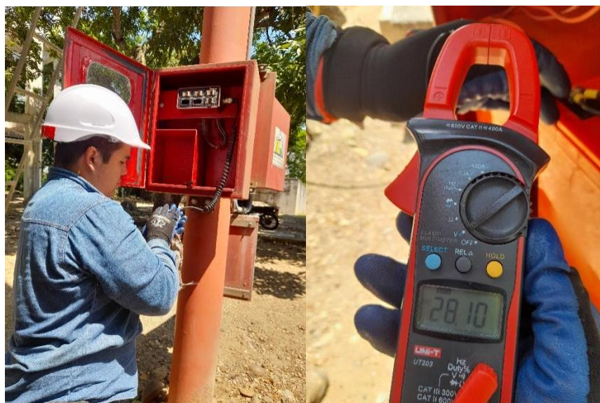
Ilustración 55: Limpieza del módulo de perifoneo y medición de voltaje de baterías
