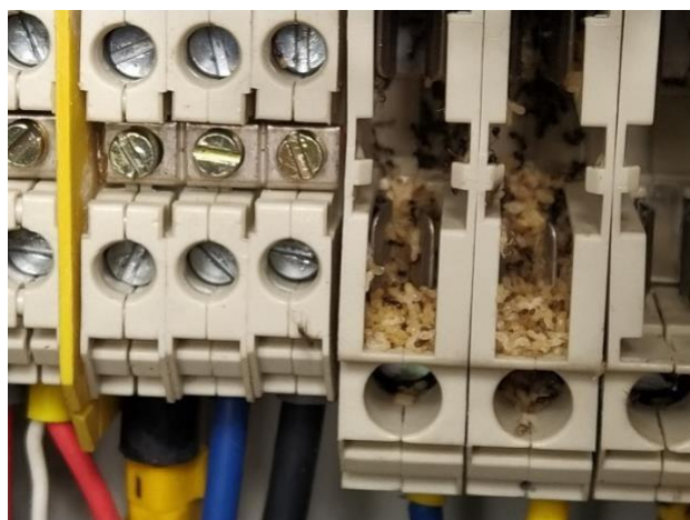
Ilustración 7: Larvas en los fusibles de sensores
