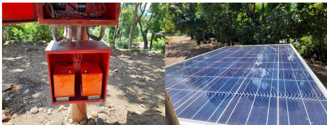
Ilustración 54: Instalación de baterías y limpieza de paneles
