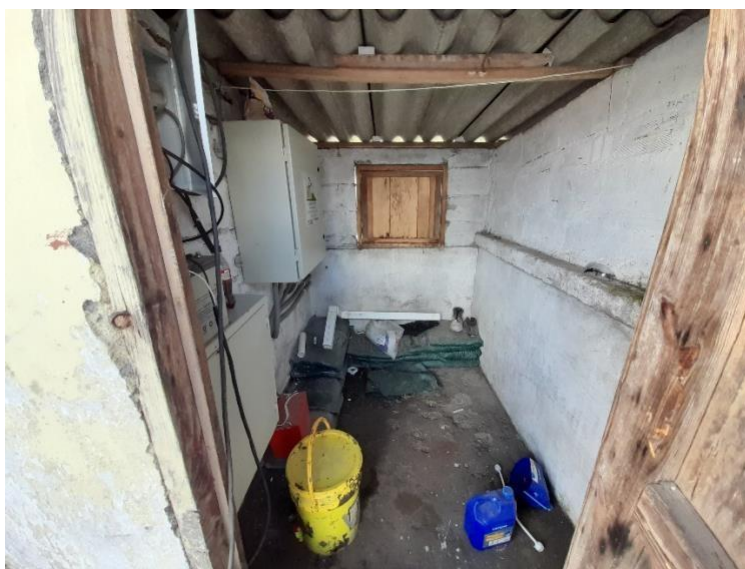
Ilustración 78: Estado inicial del cuarto de la estación.
