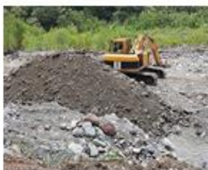
Fotos No 8 retroexcavadoras de oruga efectuando corrección del cauce.
