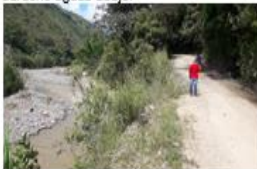
Fotos No 8 Talud socavado tiene una altura aproximada de 18 metros de altura
