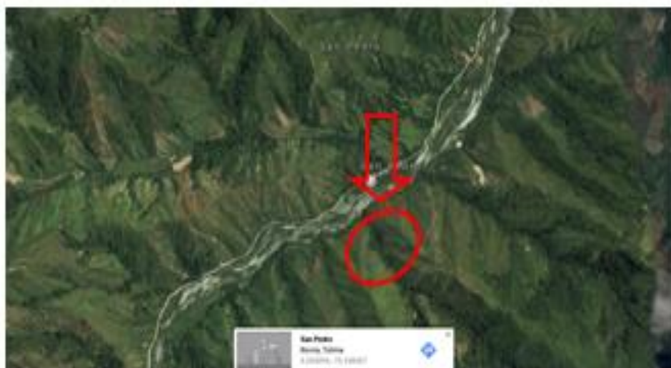
Foto No 6 Ubicación del corregimiento San Pedro, donde se presenta socavación en talud entre las viviendas y el río Cucuana.
